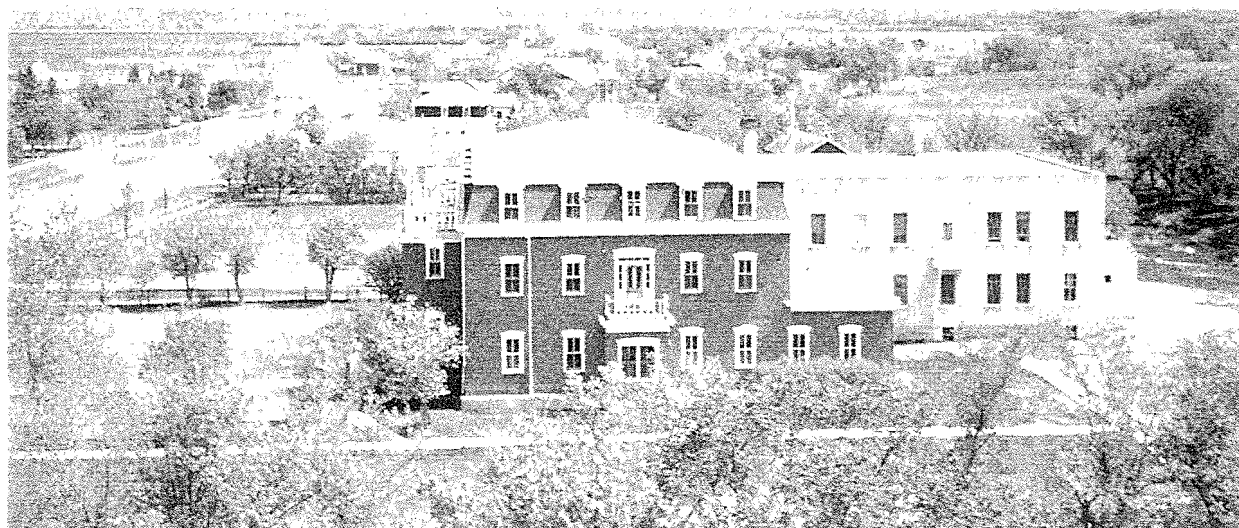
Même Couvent de 1902 recouvert de papier imitation de briques rouges. En 1928, on démolit le premier Couvent construit en 1882, pour bâtir une aile spacieuse en briques blanches 68 par 50 pieds.
